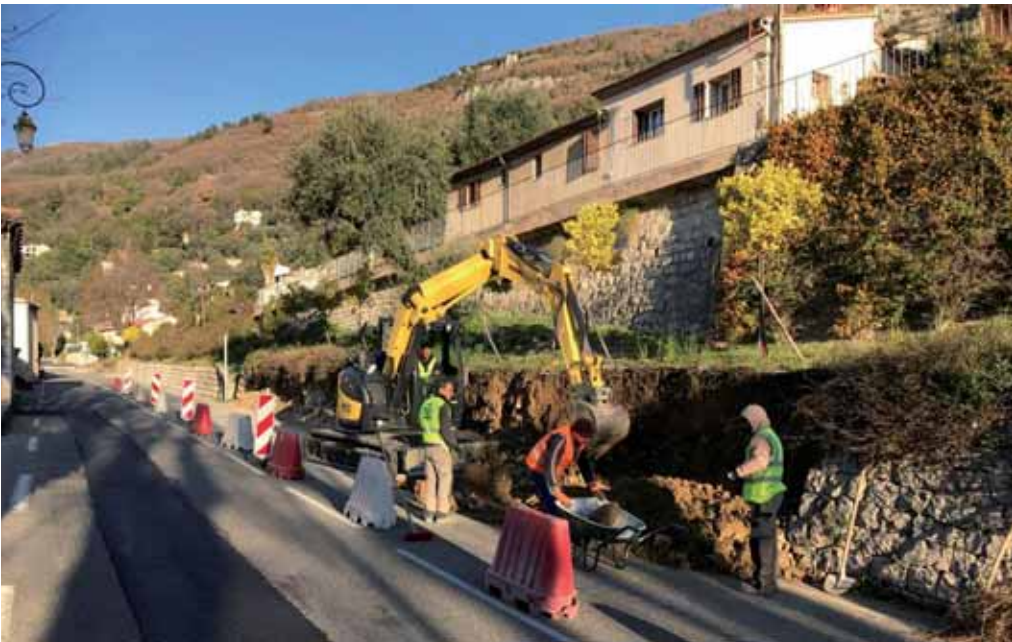
Suite à un effondrement, réfection d'un mur en pierre sur la RD2210
