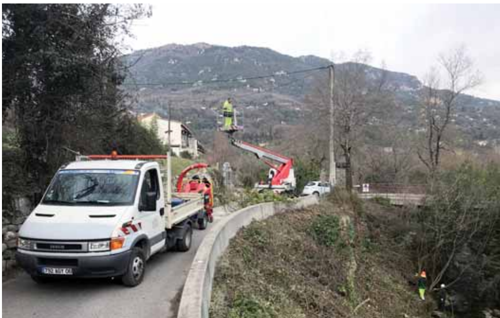
Élagage au niveau d'un des virages du chemin de L'Escure
